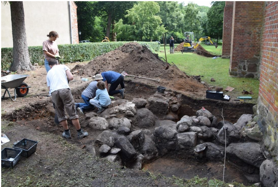
Abb. 5: Aufdeckung der Fundamentzüge in Stelle 2 (Foto: L. Augustat).
